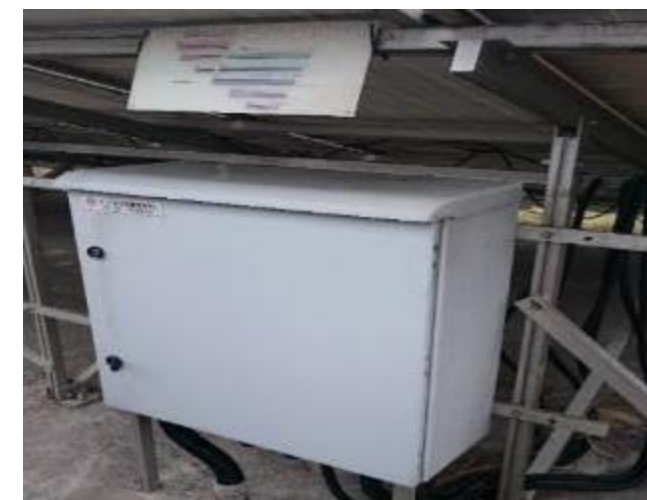
確認電路直流分接線箱
