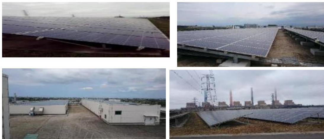
確認發電廠位置
