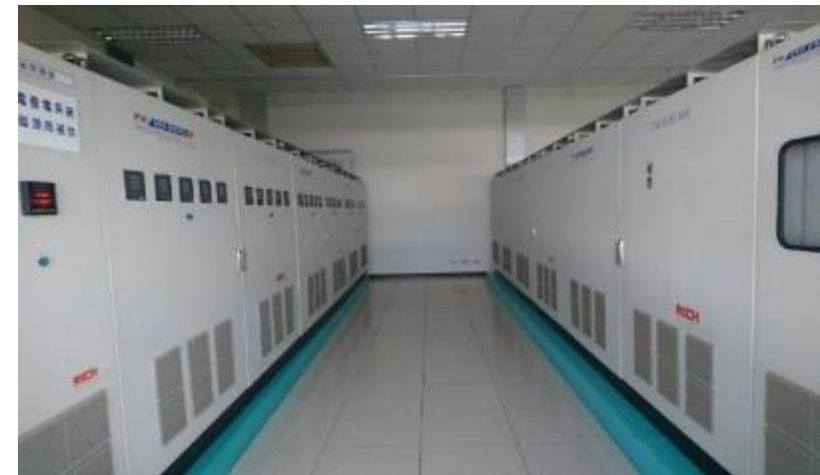
確認低壓配電盤
