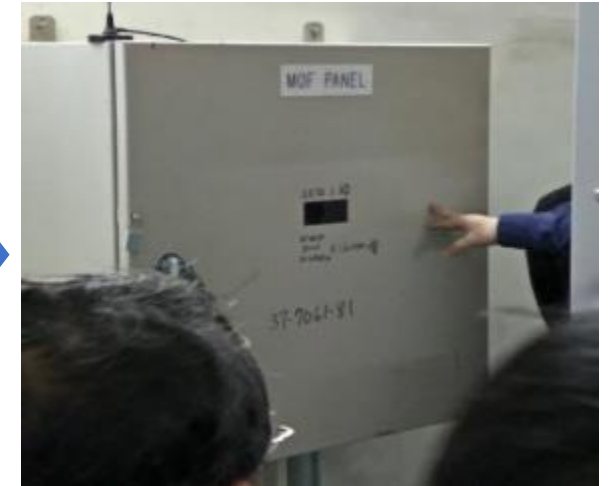
確認併網電錶規格、有效期限、校正報告及讀數。
