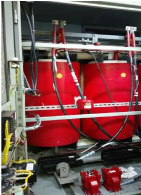
確認比壓、比流器安裝及校正報告
