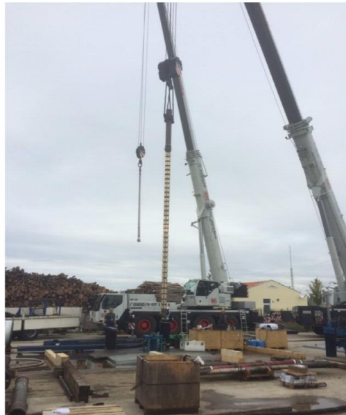
圖 6、井下泵浦結構與安裝(摘自:編修 Geothermie-Heizkraftwerk Sauerlach,SWM, 2017)
