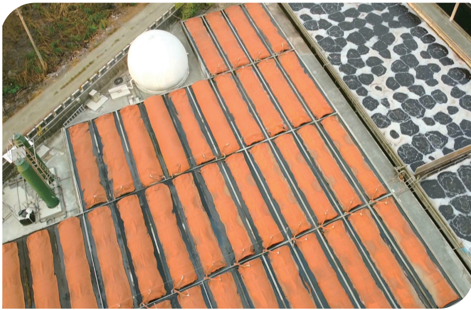
圖 5 三久牧場養豬糞尿水產生沼氣用於發電—減少碳排創造綠能
