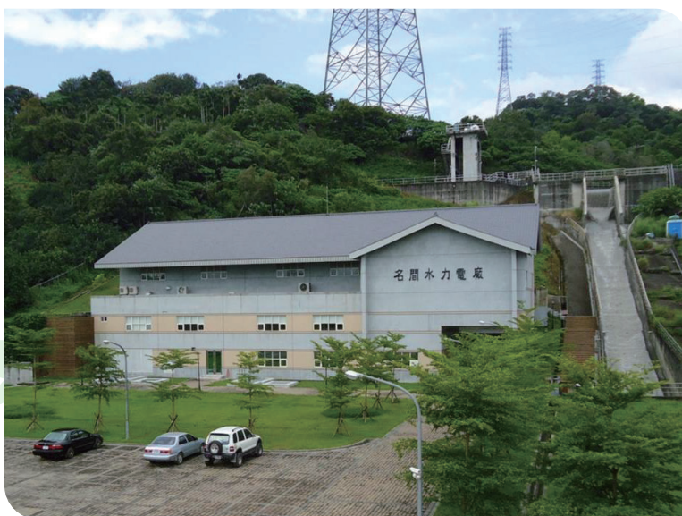
圖 4 名間電力股份有限公司水力發電廠
