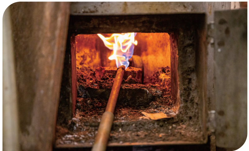
圖 1 沼氣加熱供應牧場熱水
