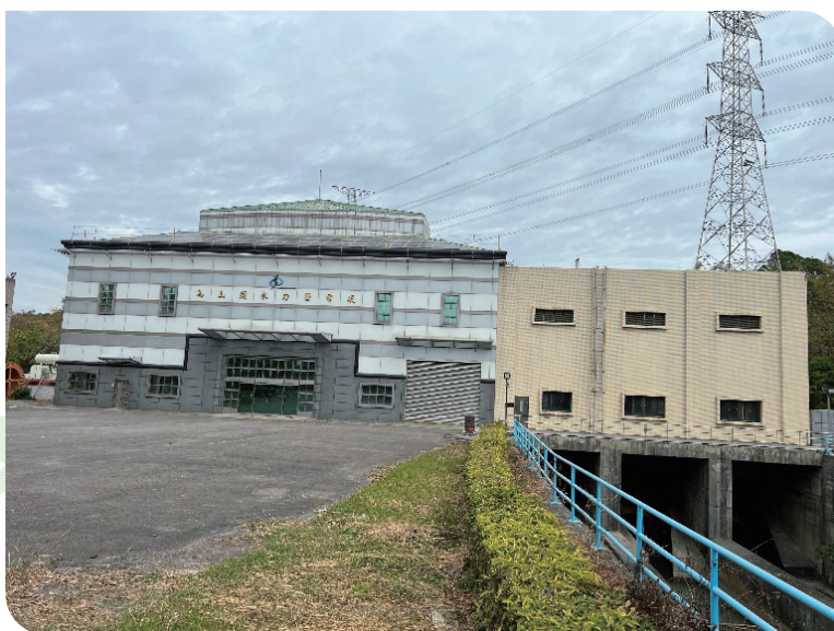
圖 3 烏山頭水力發電廠
